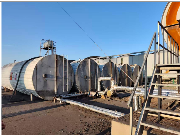
沥青罐及电加热装置现状
