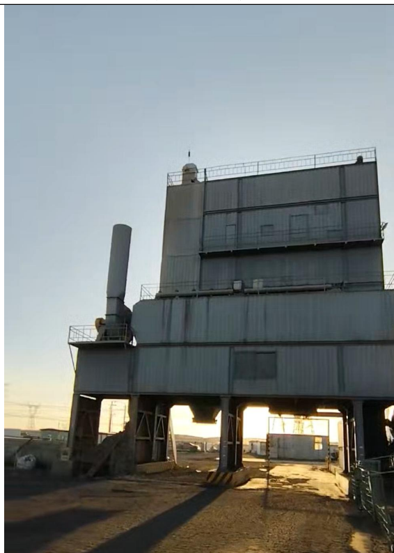
除尘装置现状
