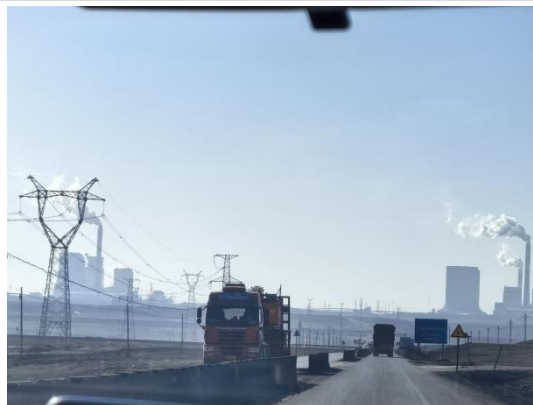
公路现场照片
