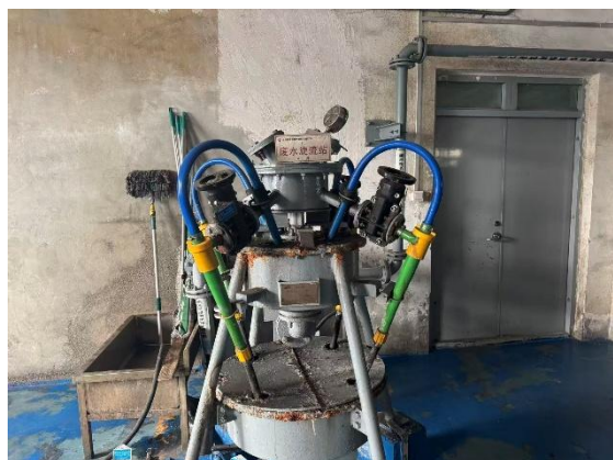
现有脱硫废水旋流站
