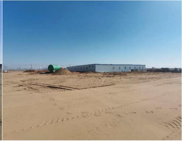
中试装置区东侧烯烃项目施工临时备件库
