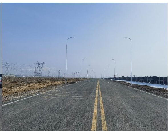
厂区北侧入厂园区道路
