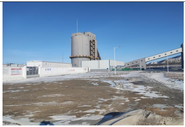
拟建 110kV 变电站
