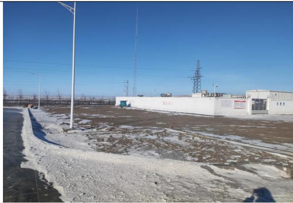
拟建 110kV 变电站
