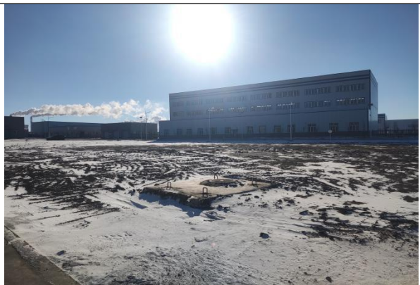
拟建 110kV 变电站
