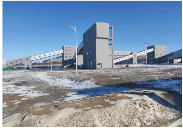
拟建 110kV 变电站
