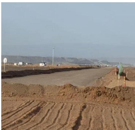
项目北侧至将二矿道路
