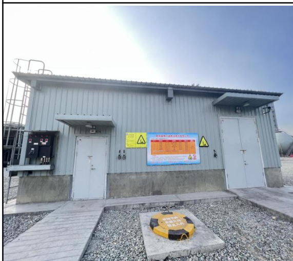
现有工程危险废物贮存库
