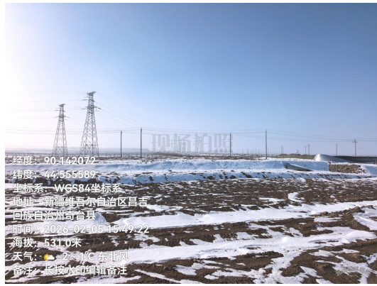
风井道路 (H) 起点现状
