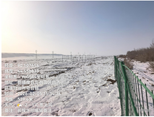
进场道路 (A) 起点现状
