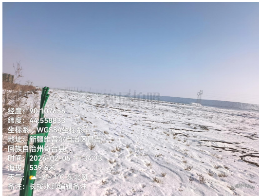
进场道路 (A) 道路沿线现状
