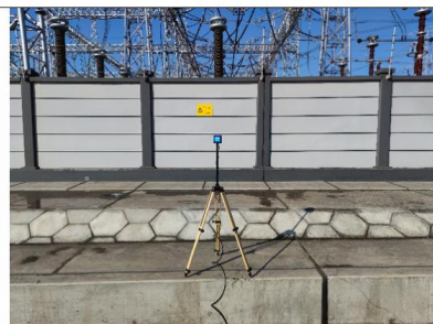
孚远 750kV 变电站厂界东侧 1#
