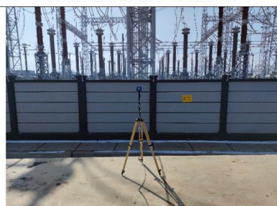
孚远 750kV 变电站厂界北侧 12#
