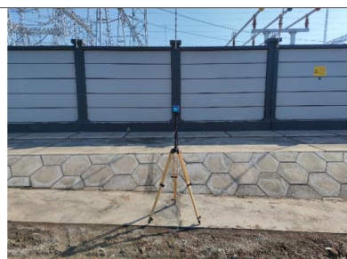
孚远 750kV 变电站厂界西侧 8#
