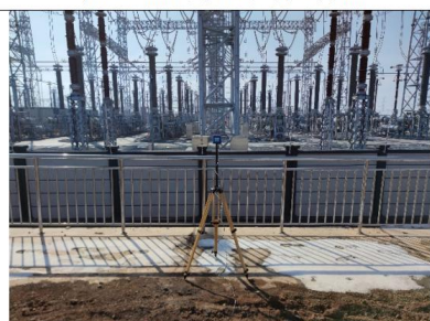
孚远 750kV 变电站厂界北侧 10#
