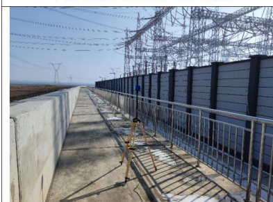
孚远 750kV 变电站厂界北侧 11#
