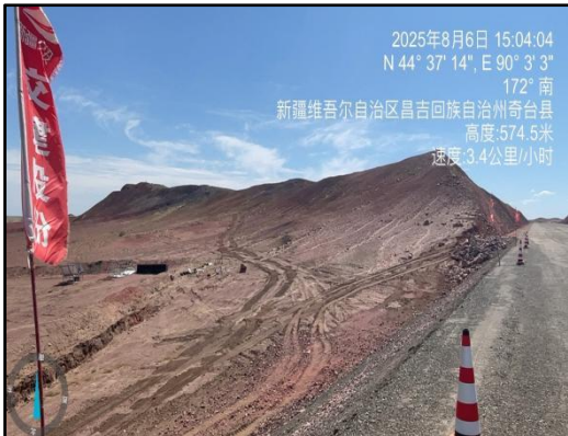
厂外输煤皮带沿线两侧植被现状
