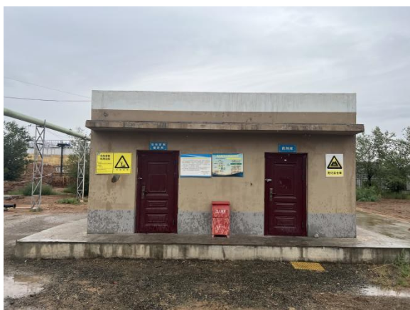
现有危废暂存间及药剂间
