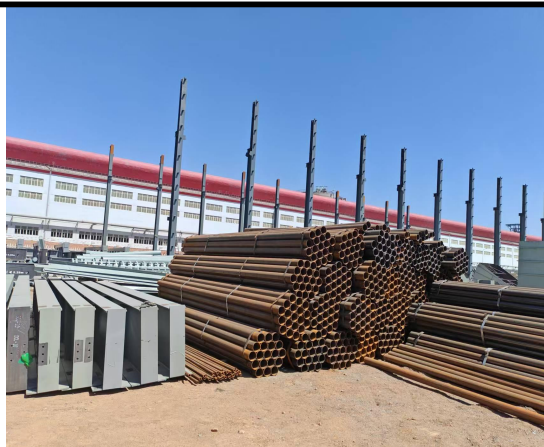
项目区现状：喷漆车间正在建设
