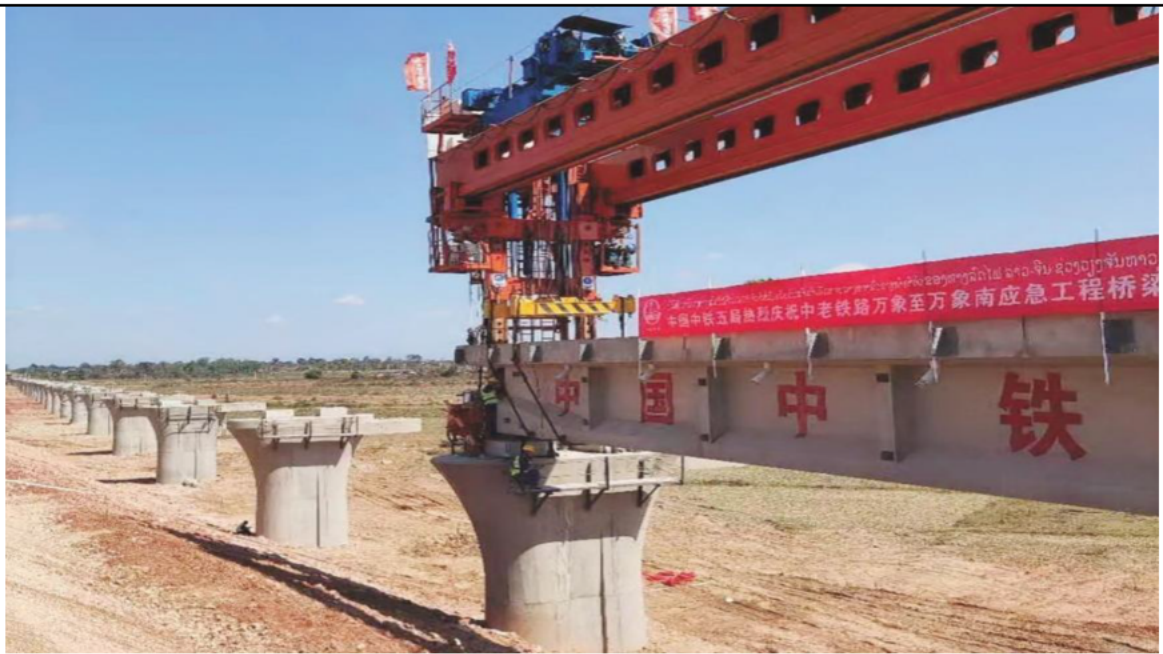
图 2-1 T 梁预制架设图
