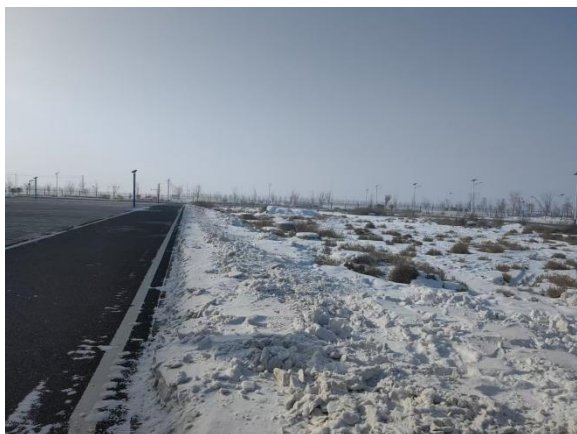
项目区北侧为绿化用地
