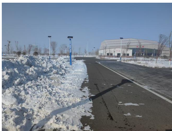
项目区西侧为内部道路
