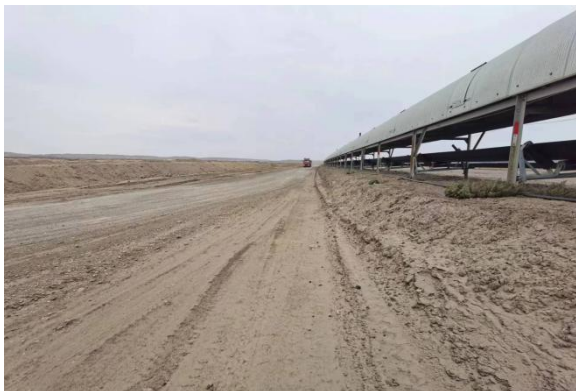
项目区东侧巡检道路
