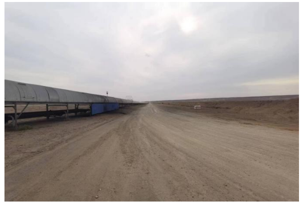
项目区西侧巡检道路
