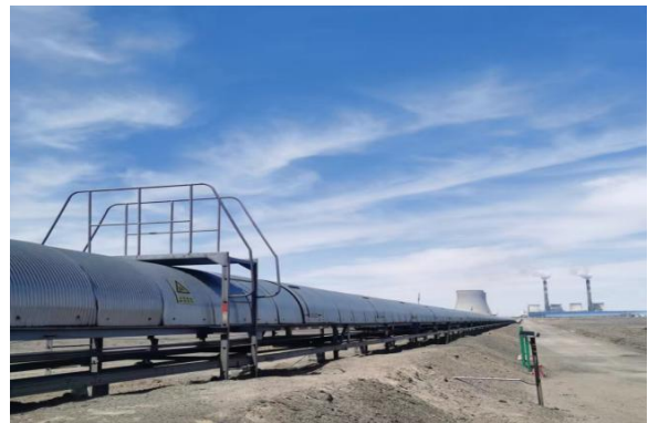
原有输煤廊道
